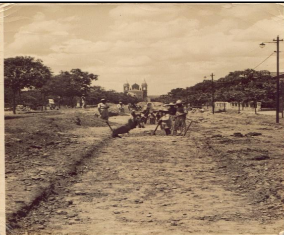
Foto 1: Construção da Avenida Frei Serafim Fonte: Arquivo Público do Estado do Piauí
